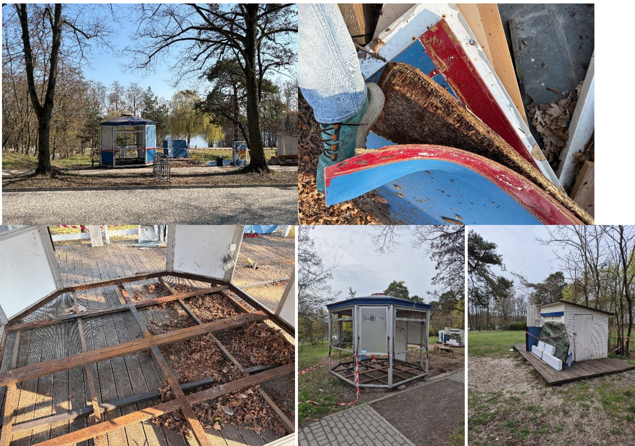
Unser Pavillon und die Terrasse werden komplett renoviert und erneuert (Fotos Alfons Wening, Steffen Schildberg)
